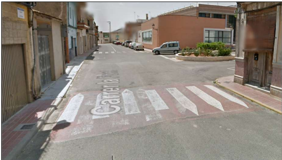
Gráfica 38. Paso de peatones sobreelevado en Carrer la Font sin continuidad con la acera.
